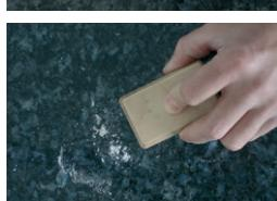
Überschüssiges Material mit AKELUX Hobel vorsichtig abnehmen. Für Kalkstein empfehlen wir den Gebrauch von Sepiaschalen. Bei Verwendung eines Oberflächenstrukturstempels\*\* entfällt dieser Schritt.
