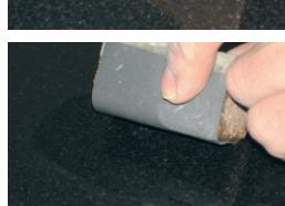
AKELUX Silikon-Schleifelein auf den AKELUX Schleif- und Polierblock legen und die Schadstelle in der Reihenfolge 2400-3200-4000 nass feinschleifen. Bei Verwendung eines Oberflächenstrukturstempels entfällt dieser Schritt.
