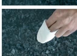
AKELUX Polierpaste auf die Reparaturstelle auftragen. Manuell mit einem Poliertuch oder der Filzseite des AKELUX Schleif- und Polierblocks oder maschinell aufpolieren (z.B. Dremel mit Filzscheibe).
