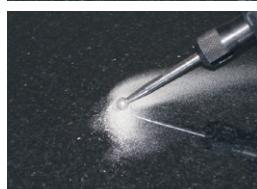
Manuelles oder maschinelles Ausfräsen der Schadstelle. Entfernen aller losen Teile sowie Staub.
