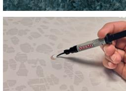
Optioneel: Om glanzende structuren of oppervlakken te imiteren, AKELUX Clear Coat zeer dun aanbrengen op natuursteen, kwartscomposiet of keramiek voor een perfecte afwerking. Daarna laten uitharden met de AKELUX LED-Powerlight\*.
