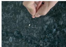
AKELUX Primer zur Haftvermittlung auftragen und diesen 60 Sekunden trocknen lassen.
