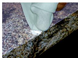
AKELUX Polierpaste auf die Reparaturstelle auftragen. Manuell mit einem Poliertuch oder der Filzseite des AKELUX Schleif- und Polierblocks oder maschinell aufpolieren (z.B. Dremel mit Filzscheibe).
