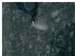
Manuelle oder maschinelle Ausfräsen der Schadstelle. Entfernen aller losen Teile sowie Staub.
