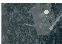
AKELUX Filler transparent liquide mit verschiedenen farbigen AKELUX Fillern mischen (max. 50% Farbanteil) und an die Objektfarbe anpassen.
